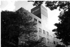
ジーエスユアサコーポレーション京都本社
