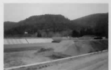
広大な面積の管理型最終処分場
