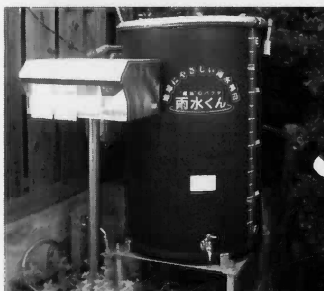
閑静な住宅街の一角にある木野環境は、雨水タンクが目印です。
